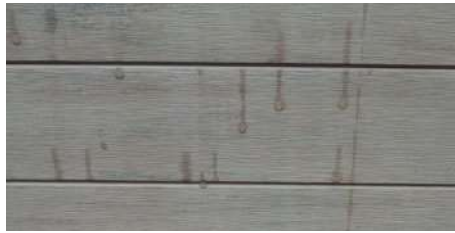
Fleckenbildung durch von Regen angelöste Partikel
